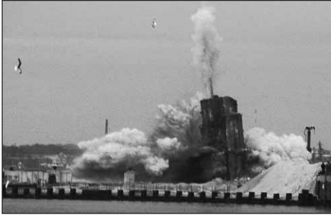
Die Sprengung des Bunkers
